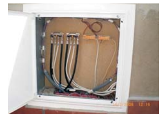
Instalación y certificación del registro secundario de la red de telefonía y TV en proyecto ICT realizado por Avandtel.
