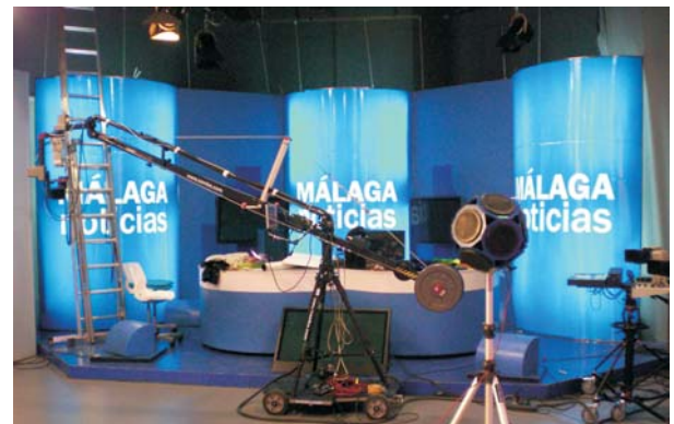
Ensayo de condiciones acústicas en Plató de TV (Málaga).
